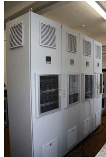
Abbildung 2: Rechts: Schaltschrank der acht netzersatzelemente
